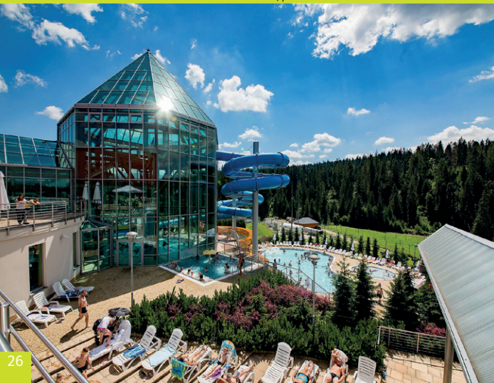
Les thermes BUKOVINA Resort à Bukowina Tatrzańska, photo arch. des thermes BUKOVINA Resort
